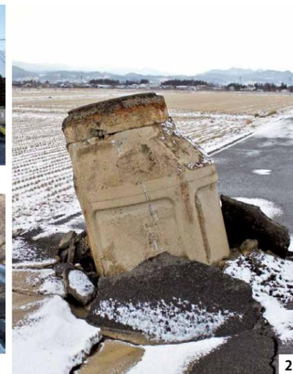
① 倒壊した住宅(塚野目) ② 液状化により地上に飛び出したマンホール(藤田) ③ 崩れ落ちた石蔵(藤田) ④ 大きく崩れた道路(小坂峠)
