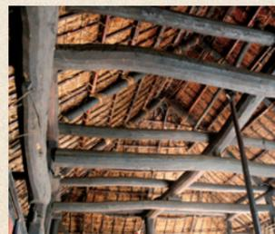
天井がなく、丸木を棟の位置で交差させる当時の一般的な造り「首又組み」
