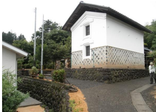
■海鼠壁を持つ漆喰の土蔵
