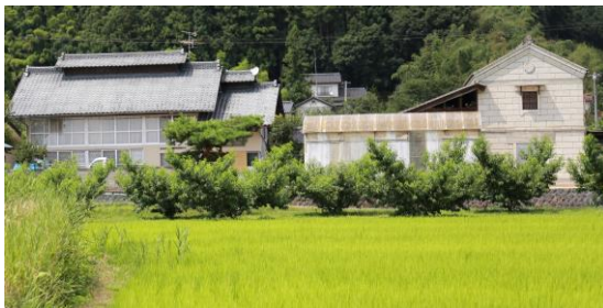
昭和 42 年(1967)建築の石蔵と養蚕住 宅 （国見町光明寺地内） 農村部の典型的な建物の組合せであ る。
