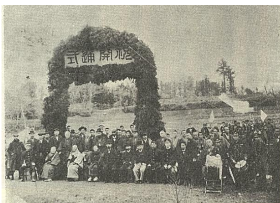
■停車場通りの開通 明治 35 年（1902）
