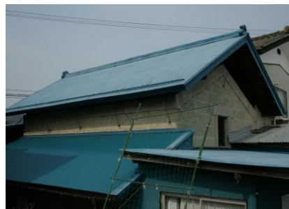
■伊藤家石蔵（大正6年（1917）建築）
