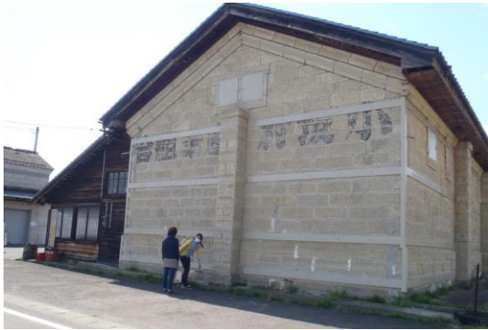
昭和 16 年(1941)建築の石蔵 （国見町内谷地内） 軍事用米を備蓄するために建築。 「小坂産業組合」と壁面に書かれてい る。壁面補強のためバットレスが付け てある。国見石使用 ※東日本大震災により鉄板補強。
