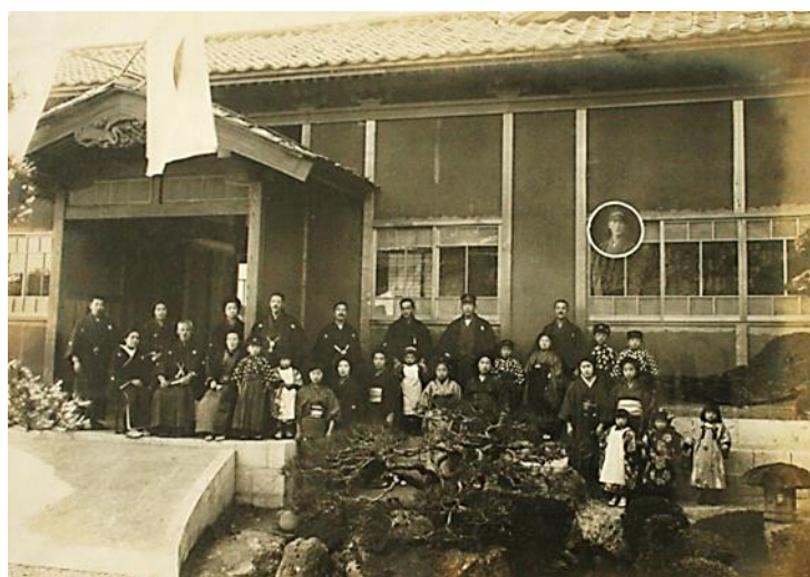
■竣工間近の奥山家住宅 大正9年（1920）
