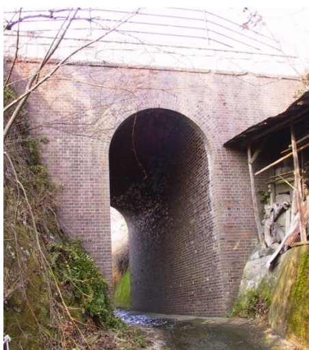
■貝田姥神沢旧鉄道レンガ橋
