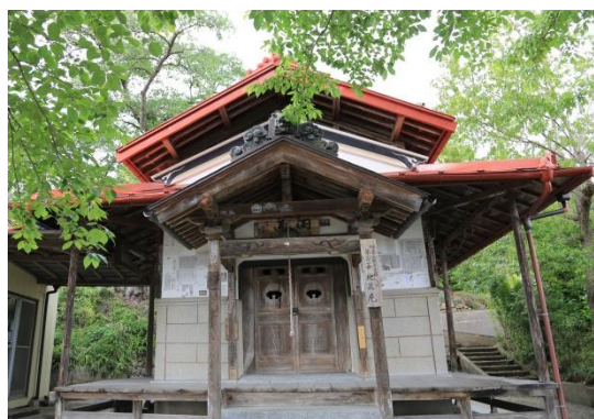
■福源寺地蔵庵観音堂
