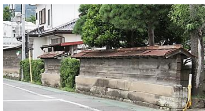
■国見石が基礎に用いられた板塀
