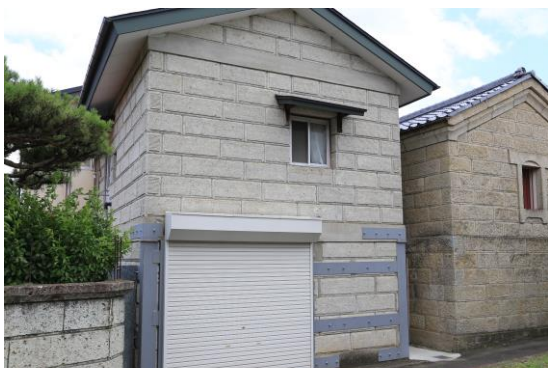
昭和 30 年～昭和 47 年(1955～1972) 年代建築の石蔵 （国見町藤田地内） 写真右側が昭和 30 年代の石蔵。左が昭 和 47 年（1972）に建てられた石蔵。 壁面の模様が機械加工になっている。 震災後補強されている。 ※国見石使用
