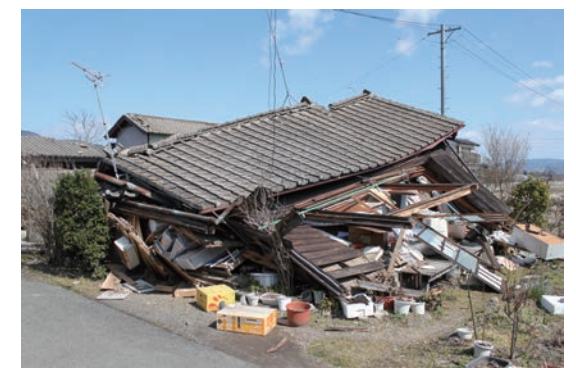
東日本大震災で倒壊した家屋
