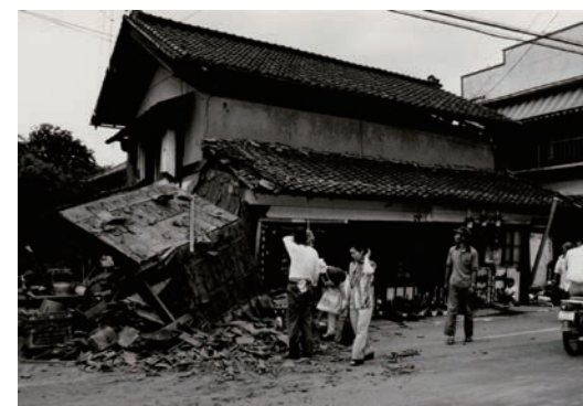
宮城県沖地震で倒壊した家屋
