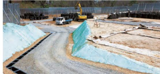
昨年11月より整備工事を進めていた、森江野1号仮置場（徳江字反畑、塚野目字福田前地内）の1期工事が完成しました。敷地面積は約5,300㎡であり、住宅除染で発生する除染土壌などのフレキシブルコンテナ約4,500袋が収容できます。タイヤ洗い場や雨水排水路も整備されており、現在除去土壌等の搬入が開始されており、町が責任を持って安全に管理します。
