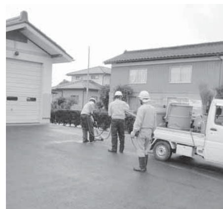
除染が進む徳江南部公民館
