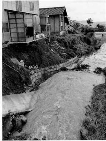
濁流で崩落した滝川の堤体(小坂太田橋付近)
