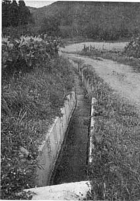
▲貝田・石畑地内町道排水工事
